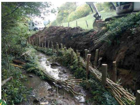
Entre ces rangées, des fagots de saules vivants sont positionnés. Puis un géotextile biodégradable en fibre de coco est posé derrière la fascine sur l'ensemble du linéaire.
