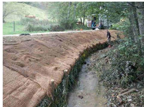
Après compactage, le talus est ensemencé puis le géotextile est rabattu sur le talus et fixé à l'aide d'agrafes métalliques. Des boutures de saules sont ensuite implantées en pied de talus. Au printemps, les boutures et le tressage constitueront avec le développement du système racinaire des saules, une protection efficace contre l'érosion.
